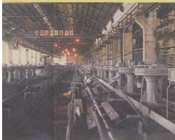
▲大型选矿磨浮车间
