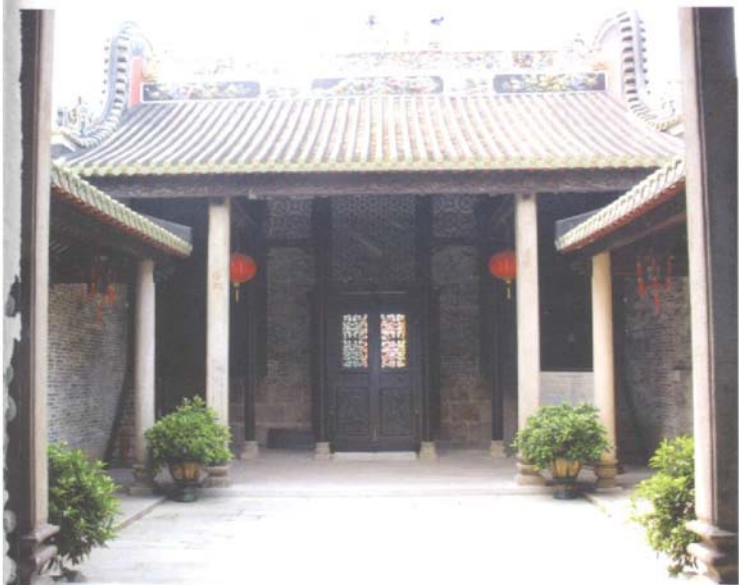
锦纶会馆是一座祠堂式的建筑。屋脊建有精美的陶塑脊饰,在屋脊的两个顶端,均建有一个用于防火的大耳锅。
