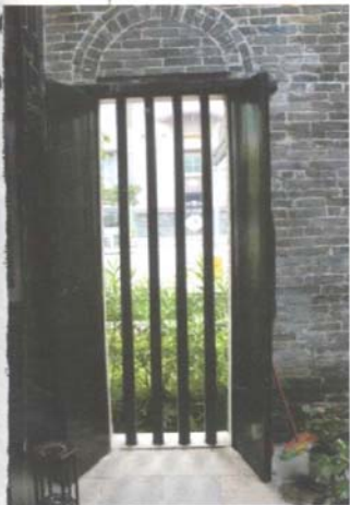
用几条粗大的木柱建造的“防盗门”,就使得会馆既固若金汤又空气流通,具有浓郁的西关特色。
