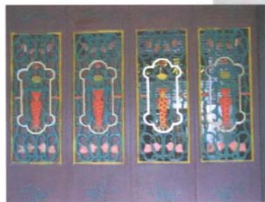
馆内有两扇用磨平的生蚝壳做的采光窗,经历了百年风雨雨雨,依然十分透亮、清晰异常。
